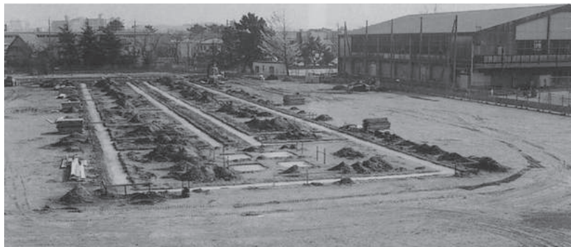
校舎建て替え グランドに仮校舎建設始まる〔平成4（1992）年〕
