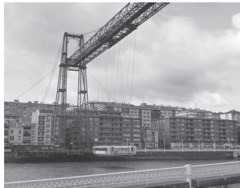
ビルバオのシンボル ビスカヤ橋〔平成18（2006）年〕
